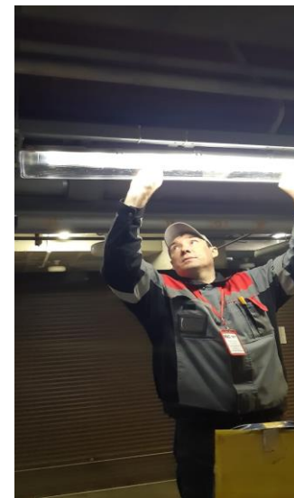
Установка ламп освещения
