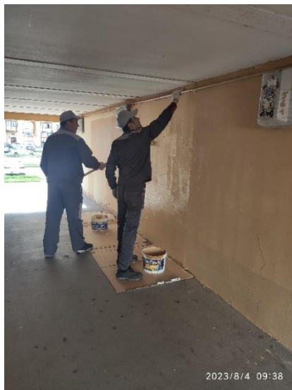
Покраска стен в арке
