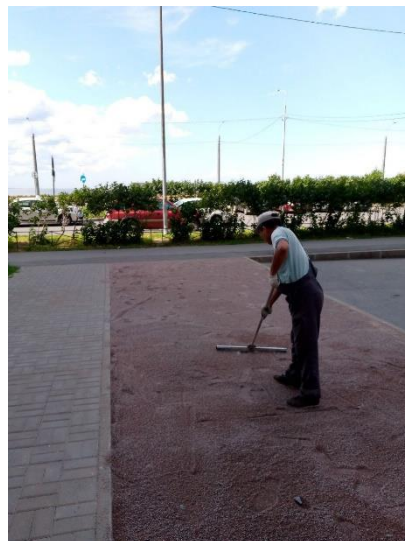
Подсыпка и выравнивание грунта Балтийский бульвар, д. 4
