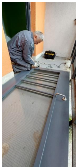
Ремонт двери ул. Парашютная, д. 61, корп. 4
