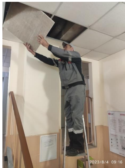
Замена потолочной плитки Ленинский пр., д. 76, корп. 1
