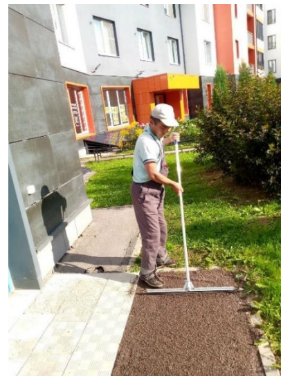
Выравнивание грунта Балтийский бульвар, д. 4
