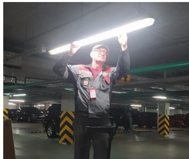
Замена светильников на паркинге пр. Медиков, д. 10
