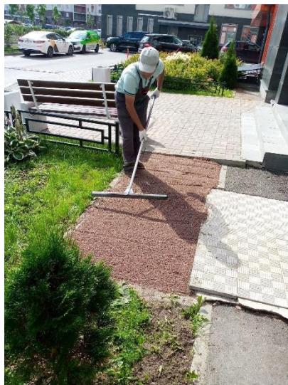
Подсыпка и выравнивание грунта Балтийский бульвар, д. 4
